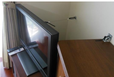
台に滑り止めの上、壁と結束バンドで引っ張り。
